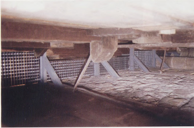
72. Erretaula nagusiaren atzealdean jarritako egitura metalikoa. Estructura metálica colocada en el reverso del retablo mayor.
