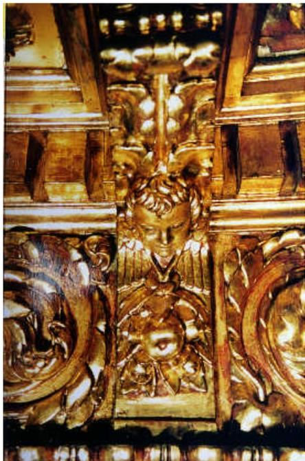
Detalle del dorado del friso del entablamento del primer piso, donde se observa la alternancia de oro bruñado y oro mate.
